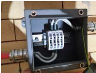
Рис. 46. Пример монтажа изоляторов термостойких керамических.
