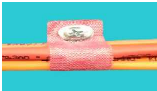
Рис. 7. Установка дюбель–хомута (Вариант 1).
