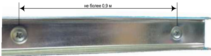
Рис. 56. Пример крепления кабель-канала металлического огнестойкого.
