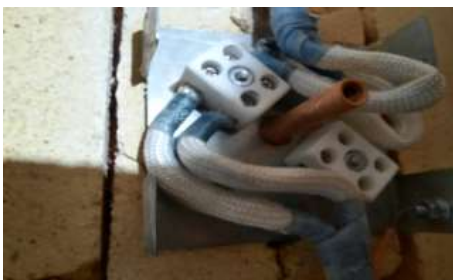
Рис. 50. Пример монтажа кабелей с использованием шнура-чулка ШК .
